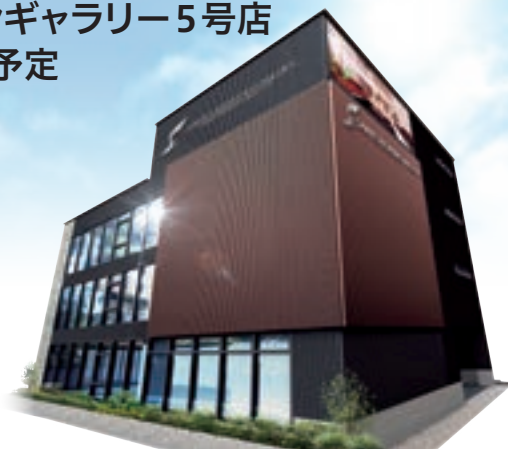
サンヨーデザインギャラリー名古屋西支店(仮称)完成予定図
